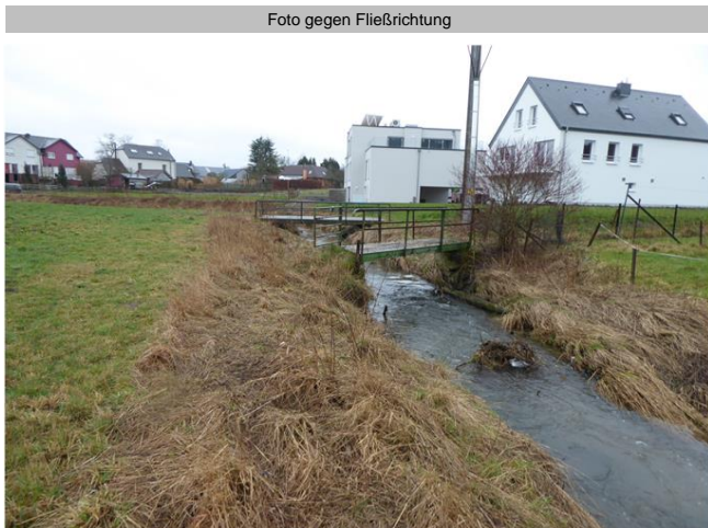
Foto gegen Fließrichtung
