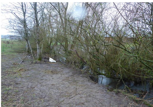
Foto gegen Fließrichtung
