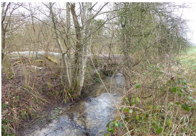
Foto gegen Fließrichtung
