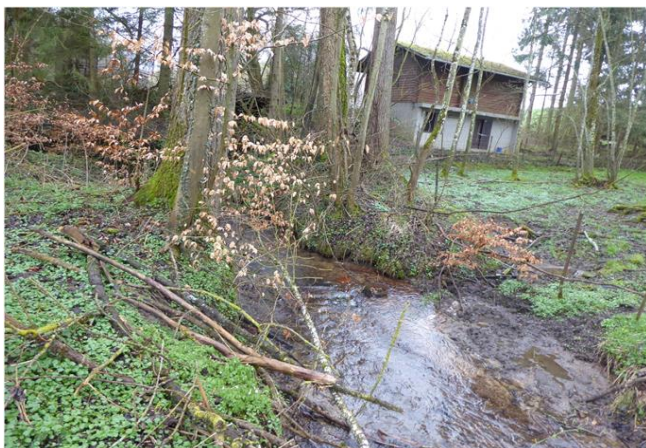
Foto gegen Fließrichtung
