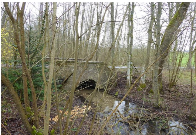
Foto gegen Fließrichtung
