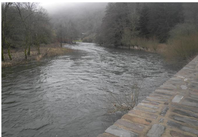
Foto gegen Fließrichtung
