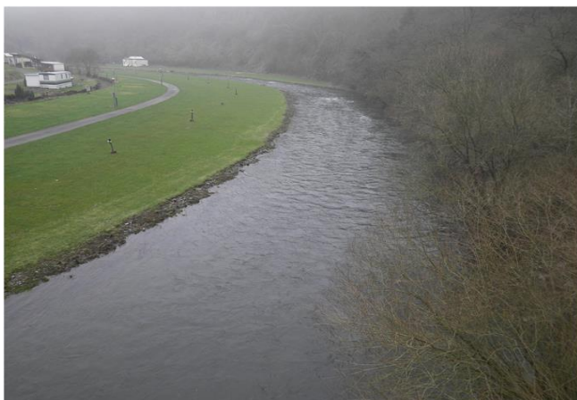
Foto gegen Fließrichtung
