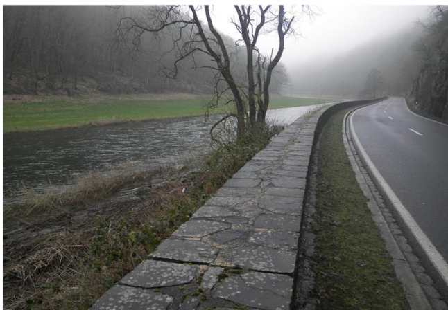
Foto gegen Fließrichtung
