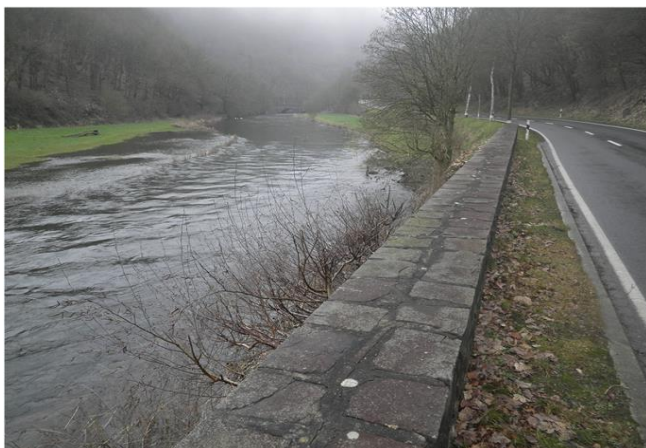
Foto gegen Fließrichtung
