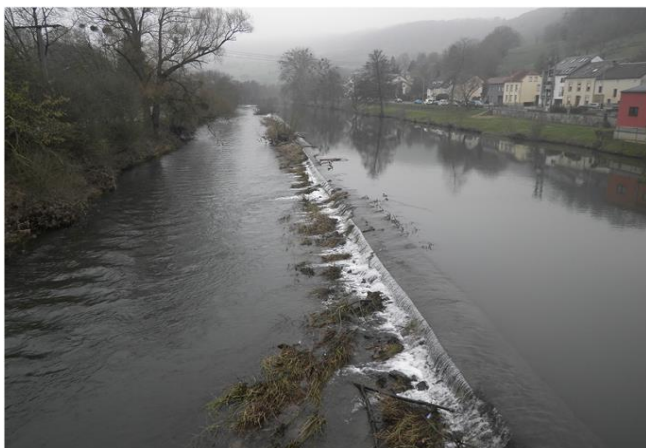
Foto gegen Fließrichtung
