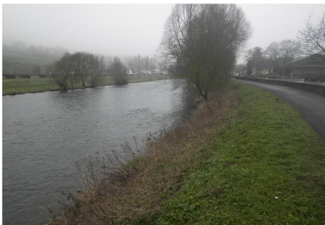
Foto gegen Fließrichtung
