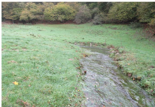
Foto gegen Fließrichtung
