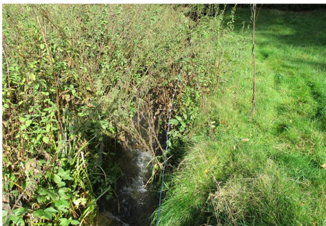
Foto gegen Fließrichtung
