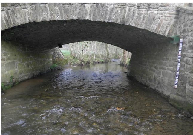
Foto gegen Fließrichtung
