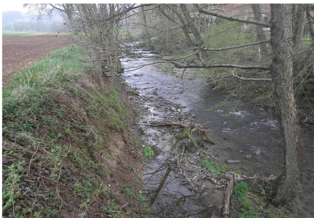
Foto gegen Fließrichtung
