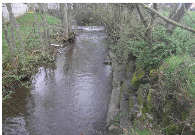
Foto gegen Fließrichtung
