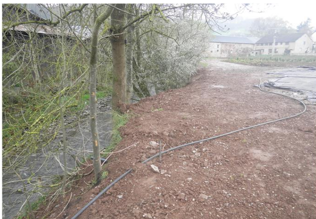
Foto gegen Fließrichtung
