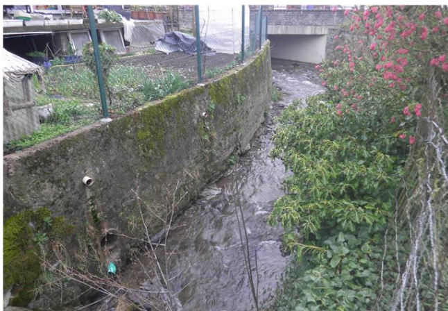
Foto gegen Fließrichtung
