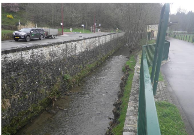
Foto gegen Fließrichtung
