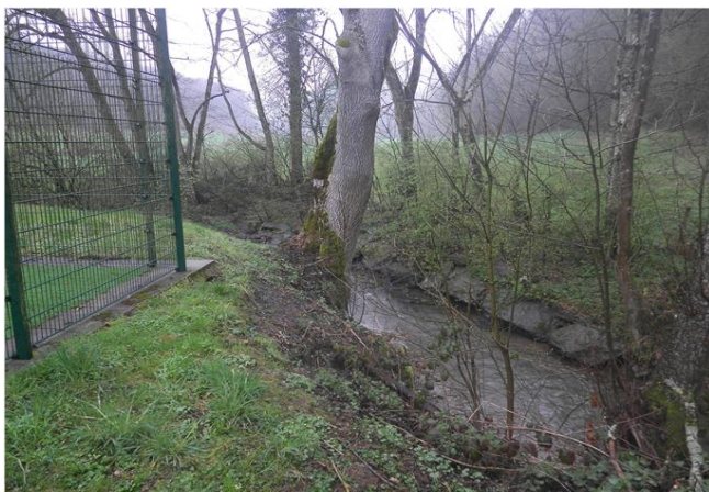
Foto gegen Fließrichtung
