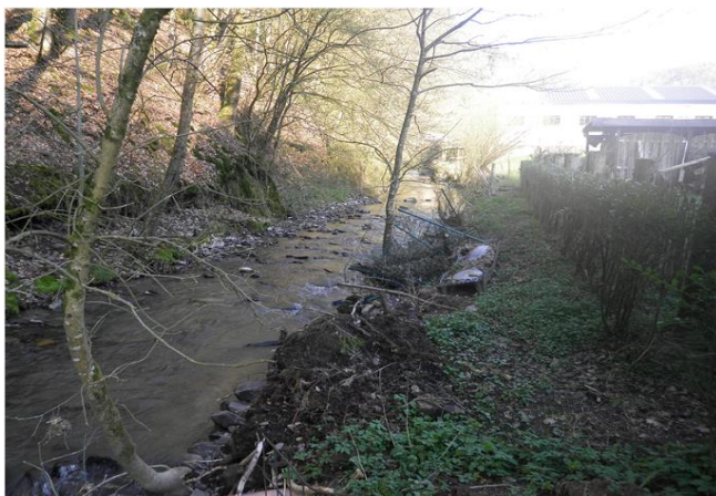
Foto gegen Fließrichtung
