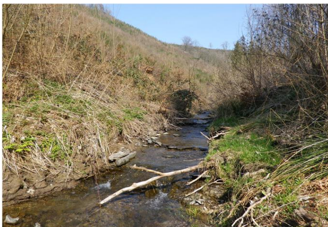
Foto gegen Fließrichtung
