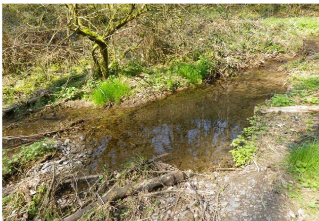
Foto gegen Fließrichtung
