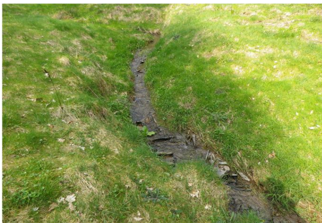
Foto gegen Fließrichtung
