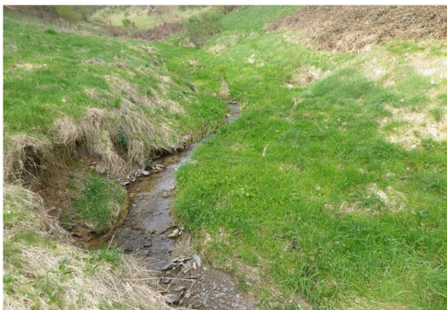
Foto gegen Fließrichtung
