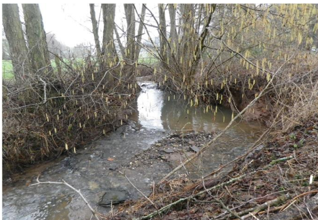
Foto gegen Fließrichtung
