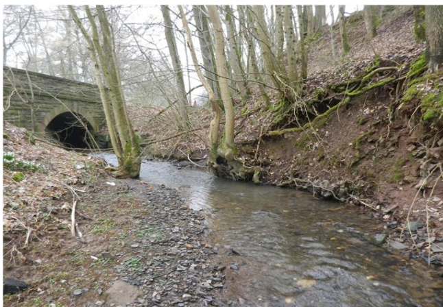
Foto gegen Fließrichtung
