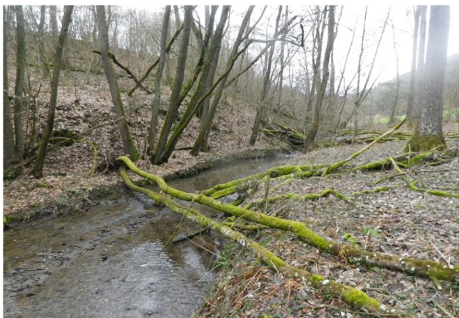
Foto gegen Fließrichtung
