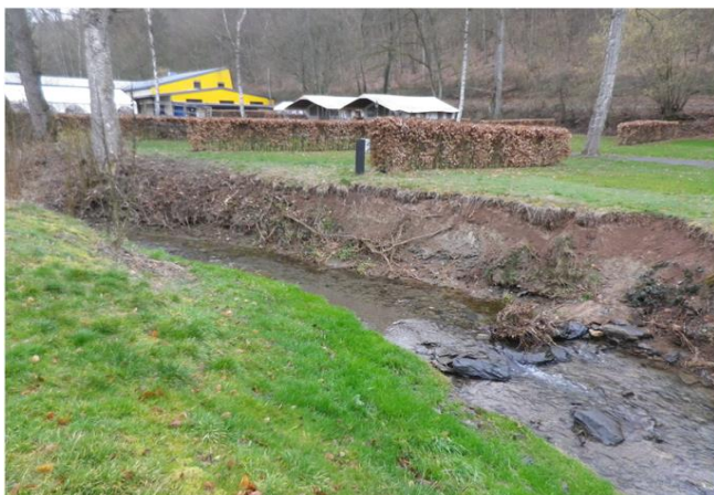
Foto gegen Fließrichtung
