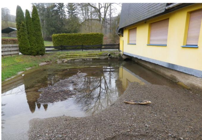
Foto gegen Fließrichtung
