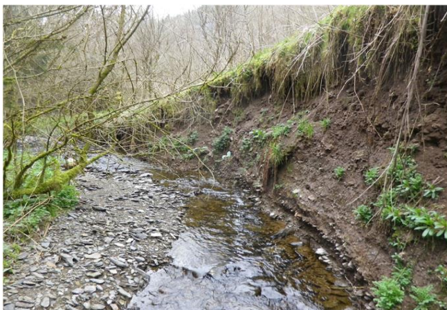
Foto gegen Fließrichtung
