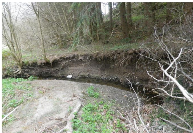
Foto gegen Fließrichtung
