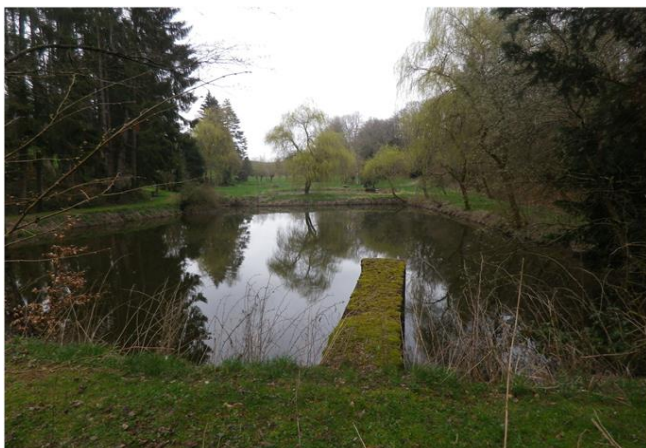
Foto gegen Fließrichtung
