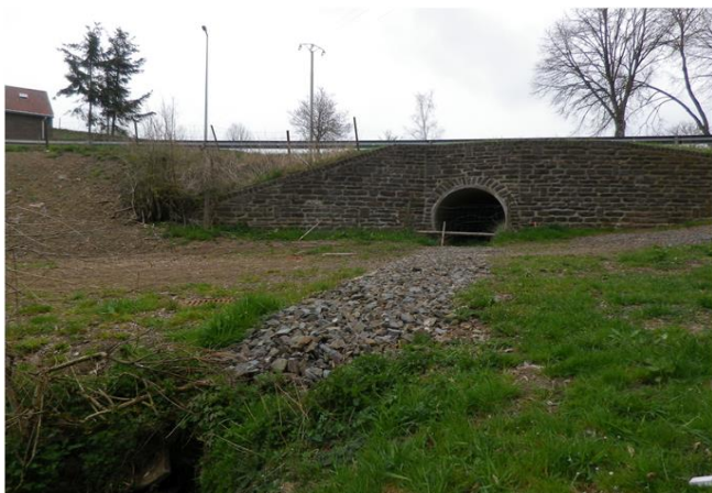
Foto gegen Fließrichtung
