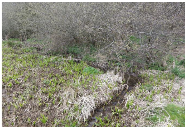
Foto gegen Fließrichtung
