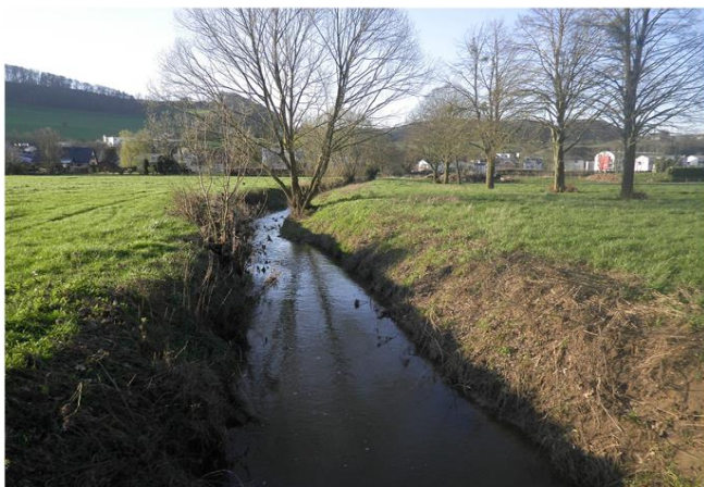
Foto gegen Fließrichtung
