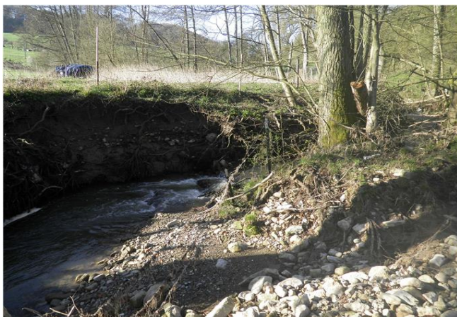
Foto gegen Fließrichtung
