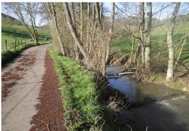
Foto gegen Fließrichtung
