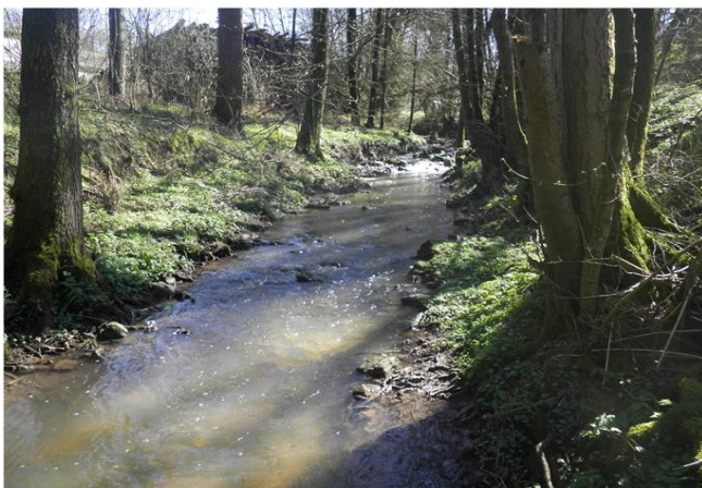
Foto gegen Fließrichtung
