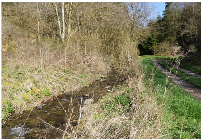
Foto gegen Fließrichtung
