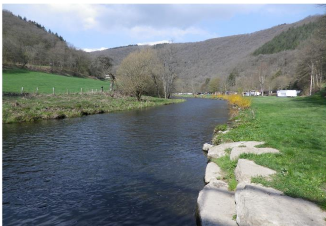
Foto gegen Fließrichtung
