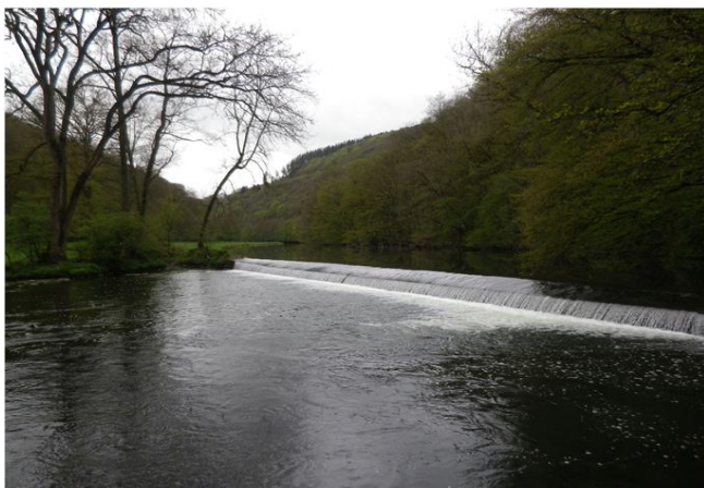
Foto gegen Fließrichtung
