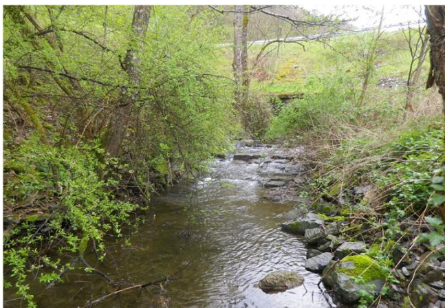
Foto gegen Fließrichtung
