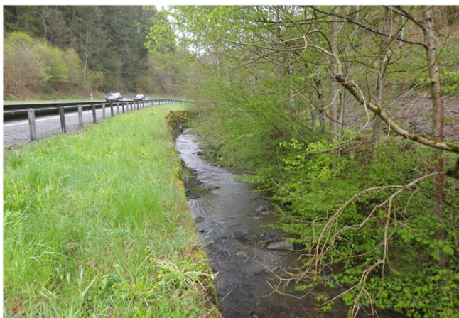
Foto gegen Fließrichtung
