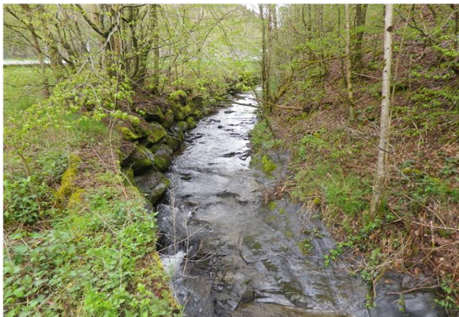
Foto gegen Fließrichtung
