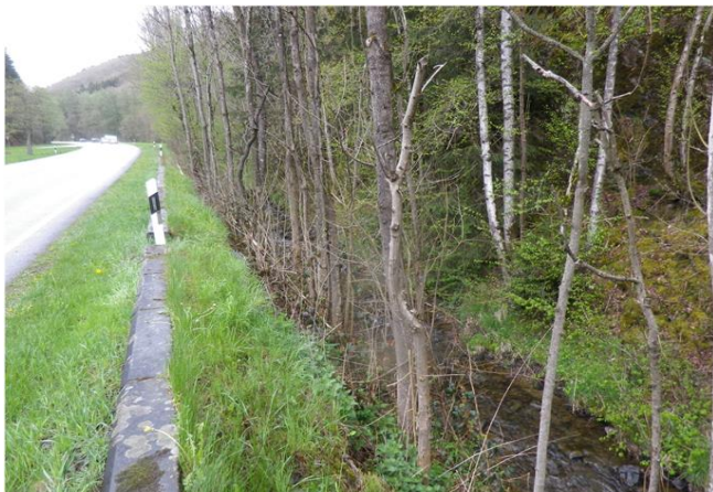
Foto gegen Fließrichtung
