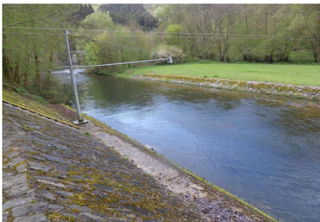
Foto gegen Fließrichtung
