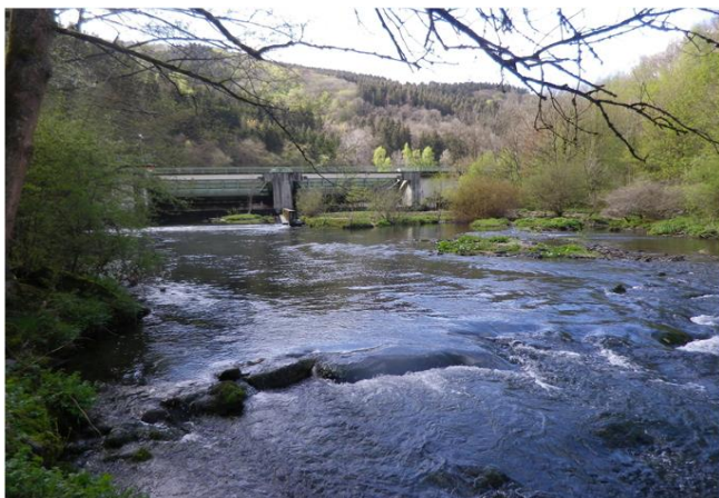
Foto gegen Fließrichtung
