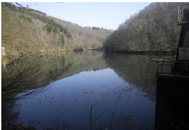
Foto gegen Fließrichtung
