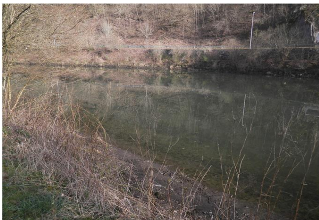
Foto gegen Fließrichtung
